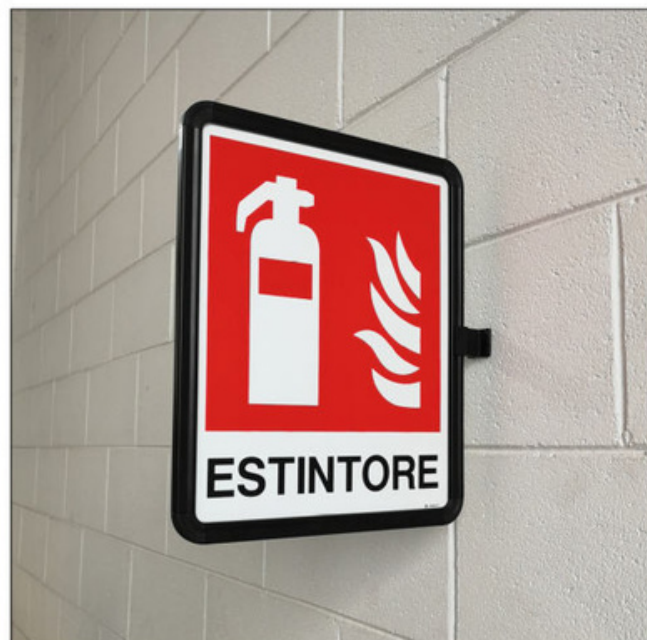
INSTALLAZIONE DI SEGNALI BIFACCIALI
