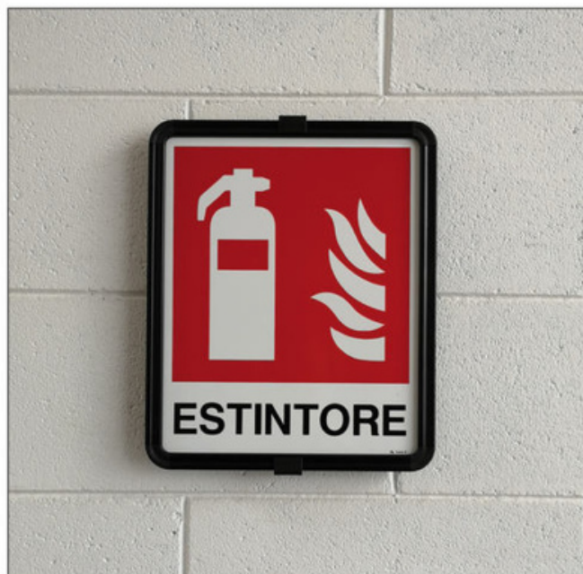
INSTALLAZIONE DI SEGNALI MONOFACCIALI
